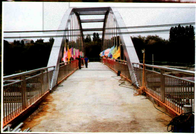
跨河滩路拱型过街人行天桥
