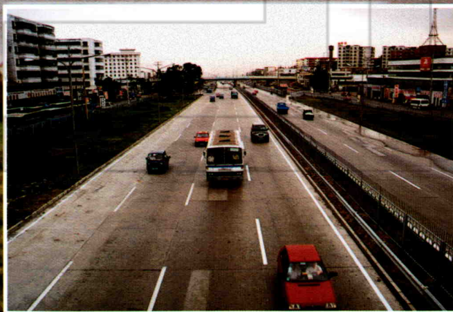
竣工通车的河滩快速路
