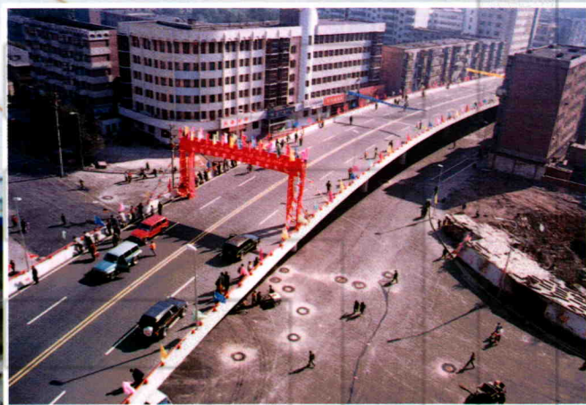
新民路高架桥
