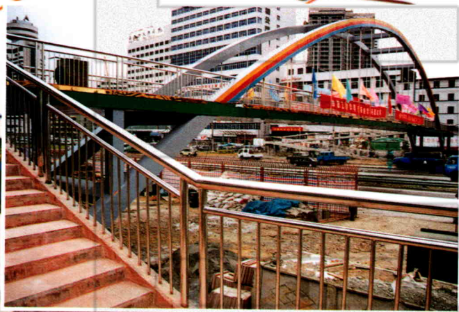
跨河滩路拱型人行天桥
