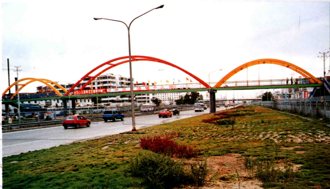
跨河滩快速路三联拱人行过街天桥
