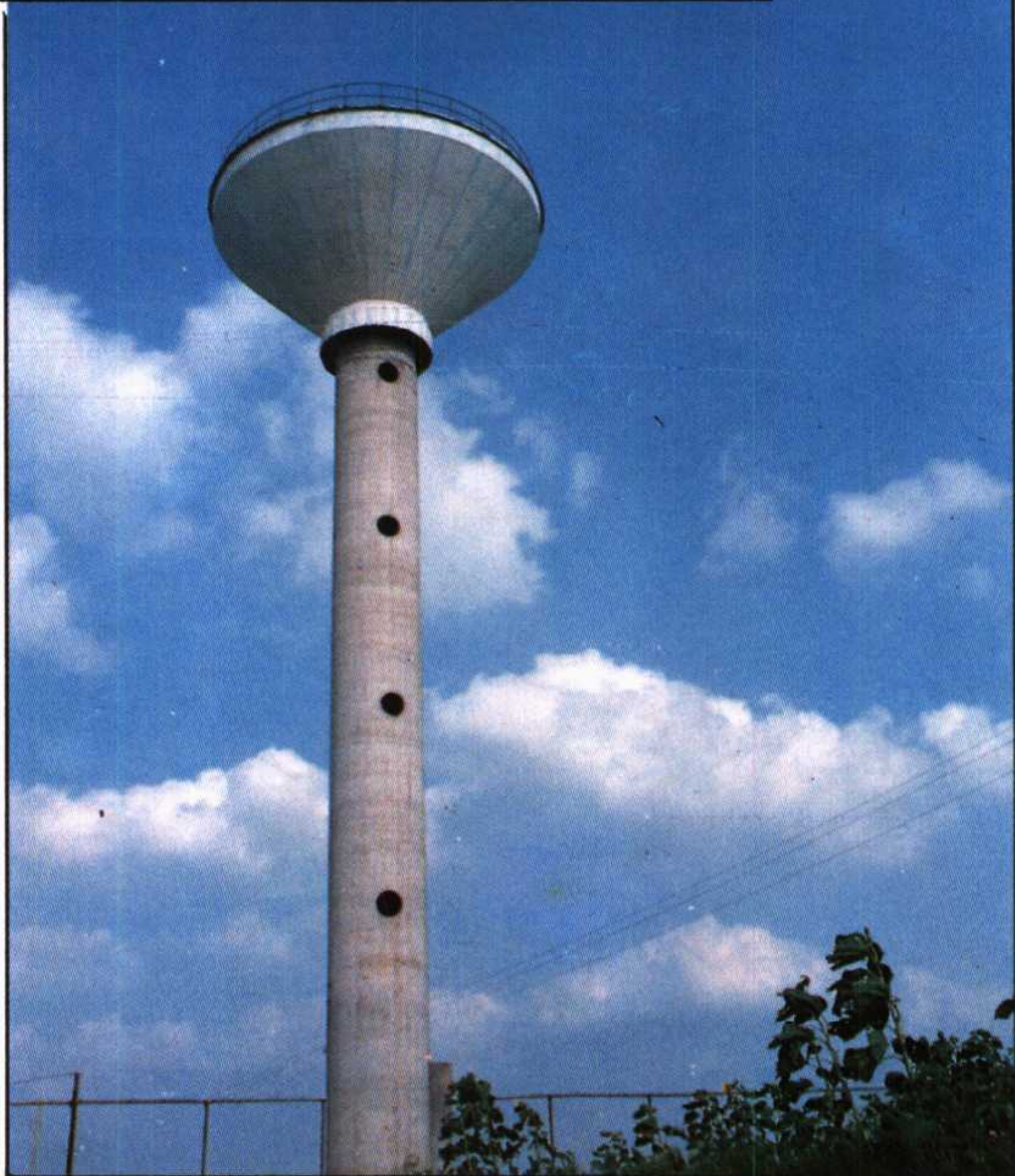
△徐州万寨港专用线 500 吨倒锥水塔
