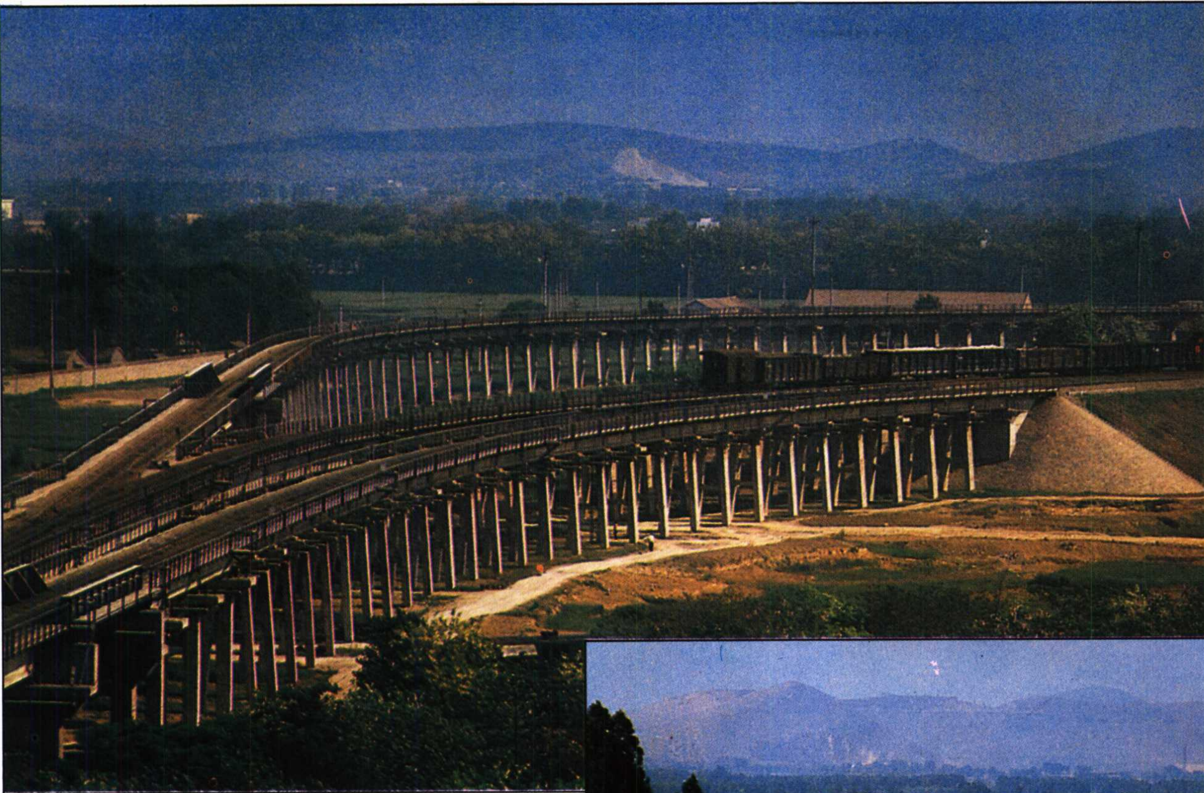
△徐州枢纽大山一、二号特大桥 全长 3486.9 延长米(其中二 号特大桥获铁道部优质工程)
