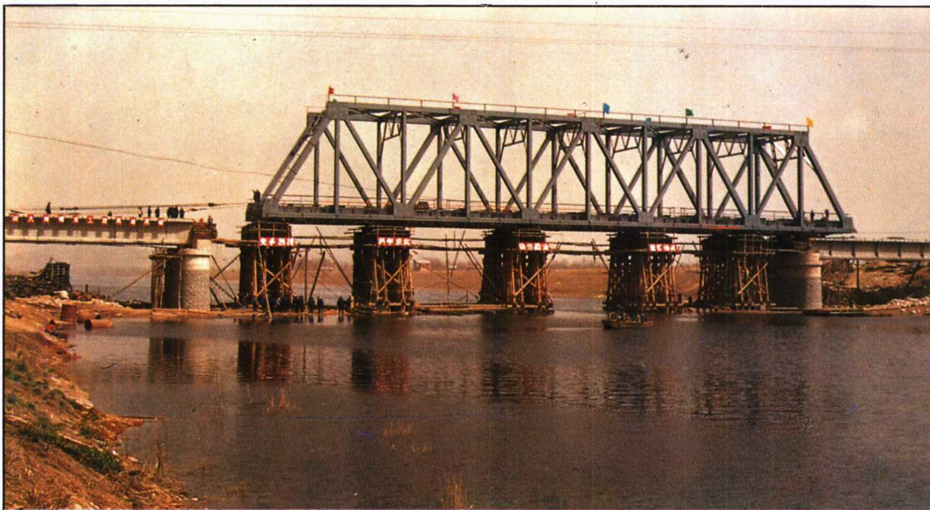
◁徐枢茅夹线京杭大 运河栓焊梁大桥， 双线桥全长 329.6 米(铁道部优质工 程)
