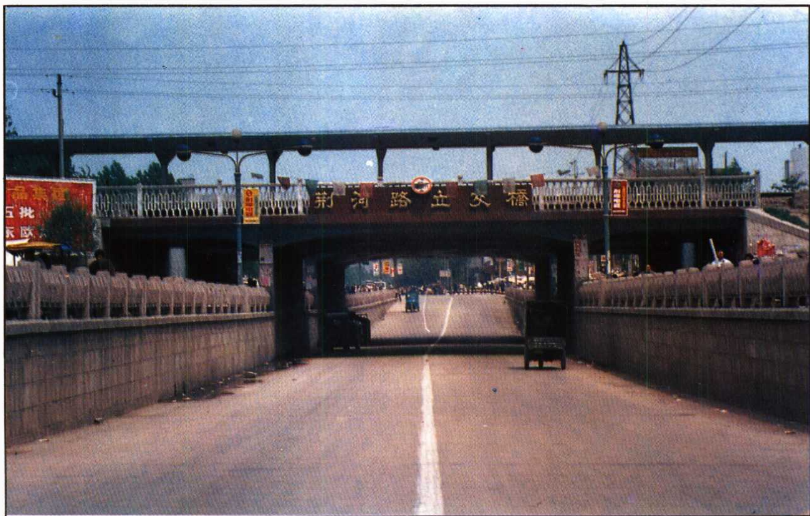
▷津浦铁路滕州市荆河路立交桥
