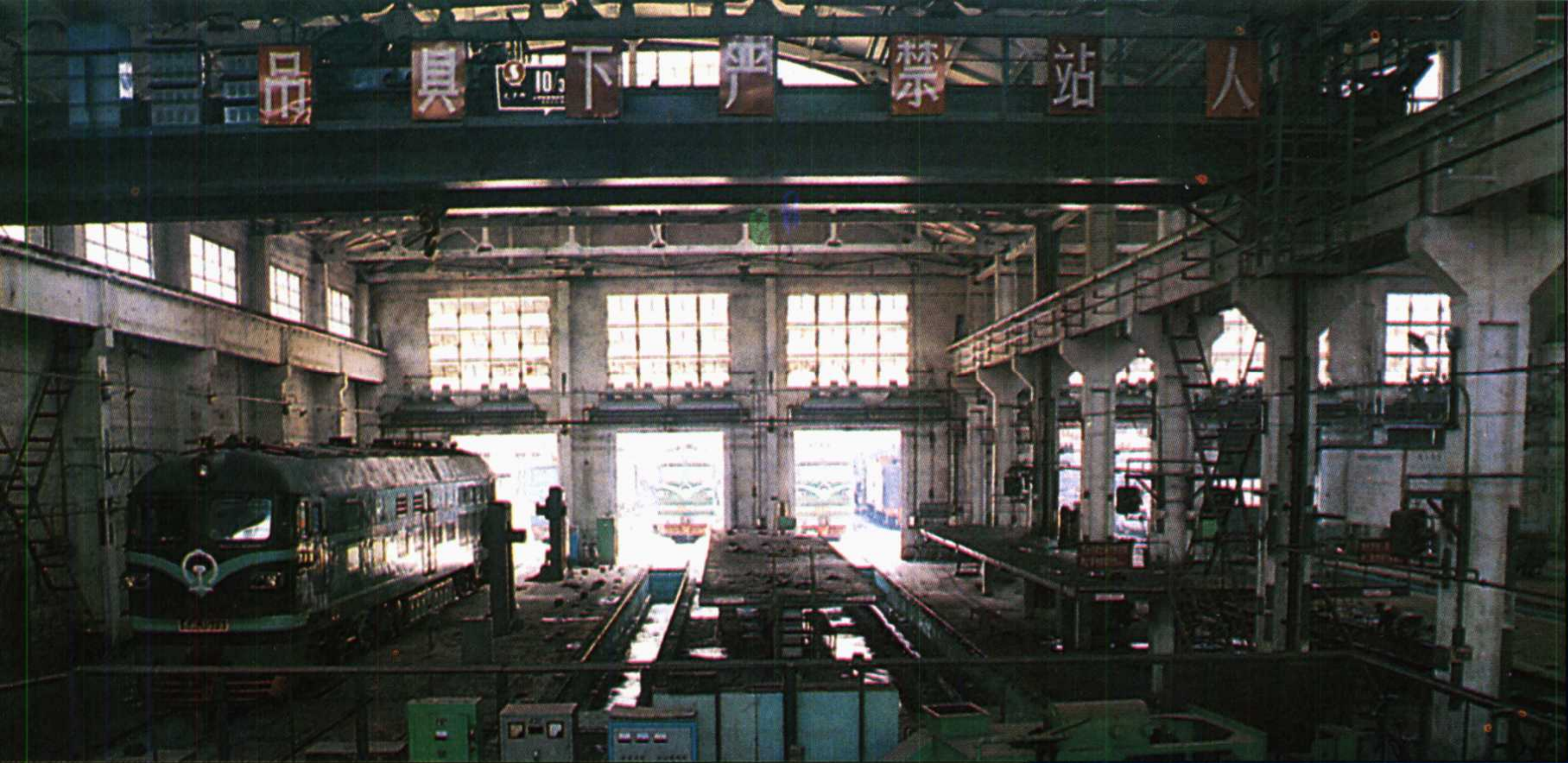
徐州机务段内燃机车定修库
