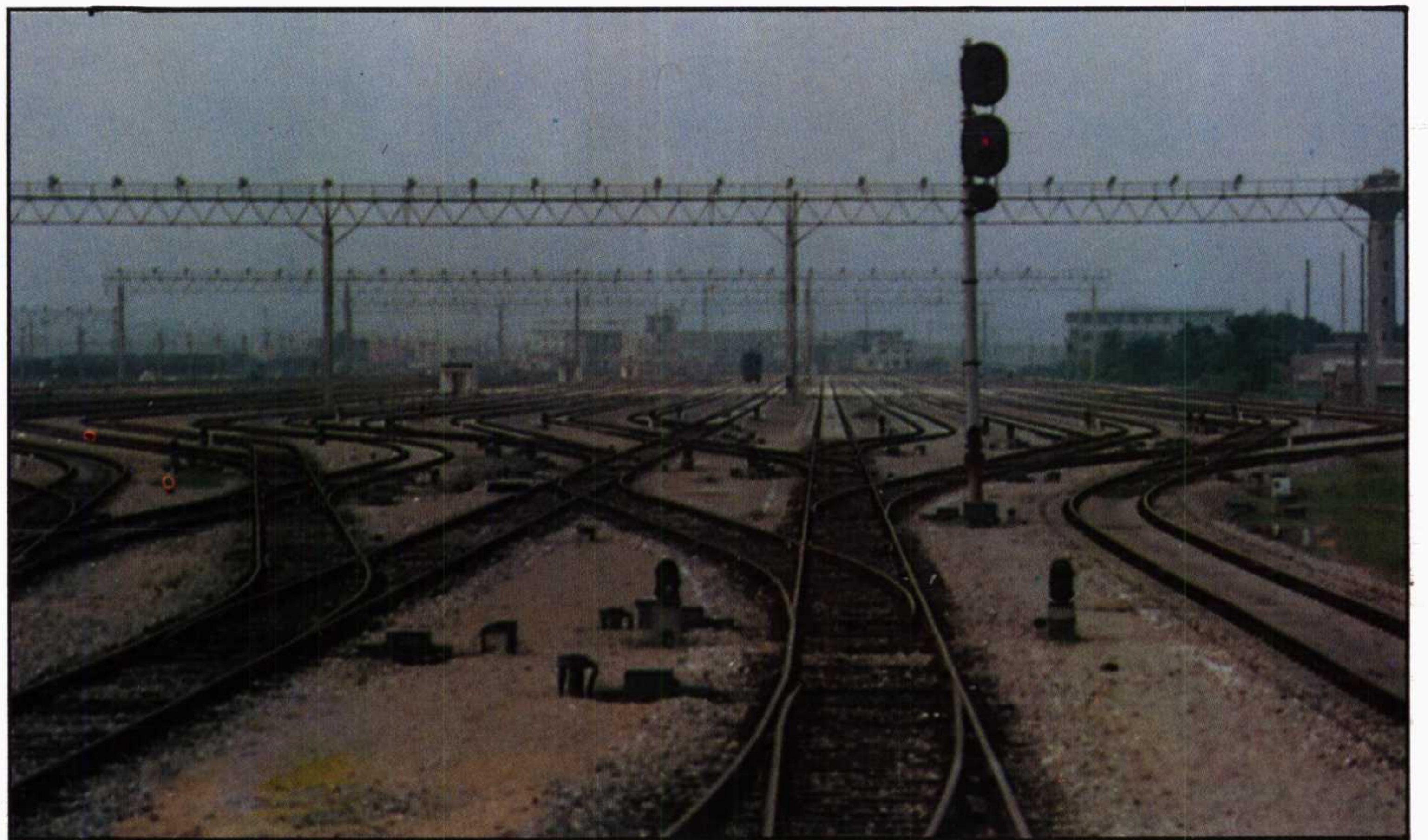
△徐州枢纽上行出发场南咽喉区
