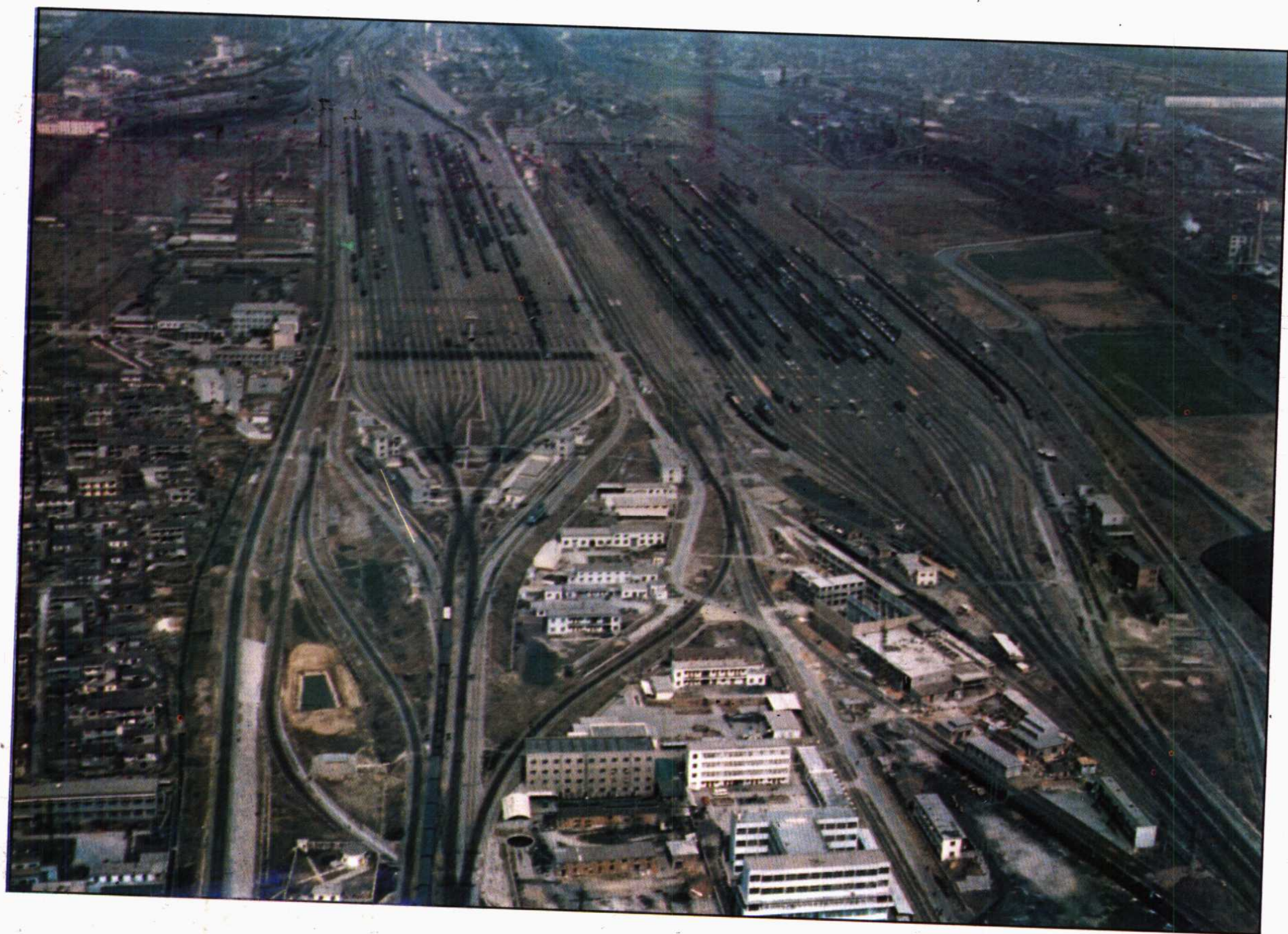
△徐州铁路枢纽扩建工程
