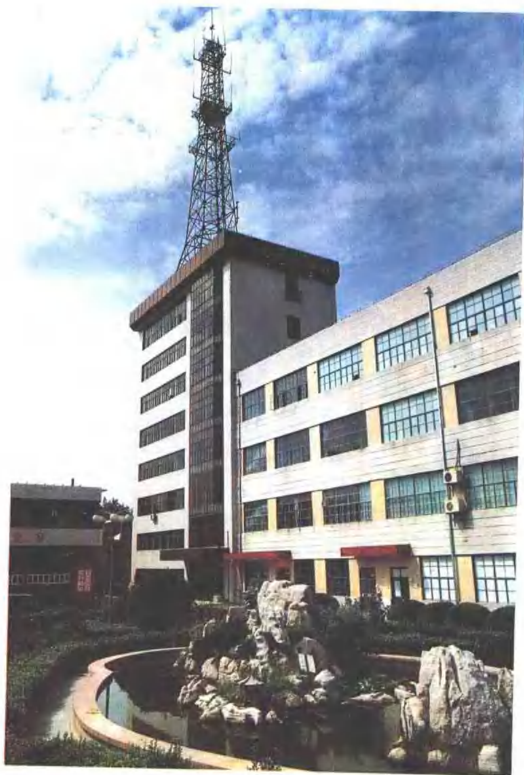
青州市邮电局综合通信楼
