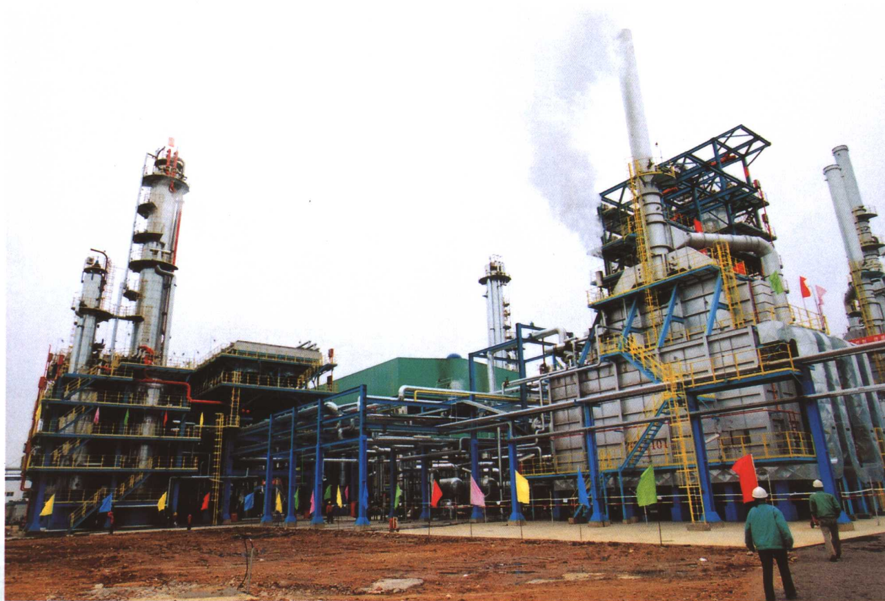
100 万吨 / 年中压加氢裂化装置
