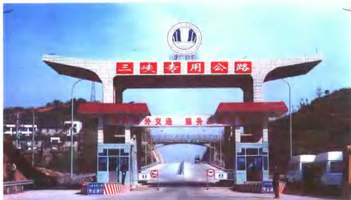
▲ 1996年10月16日，铁一院勘测设计的三峡工程对外交通专用公路建成通车
