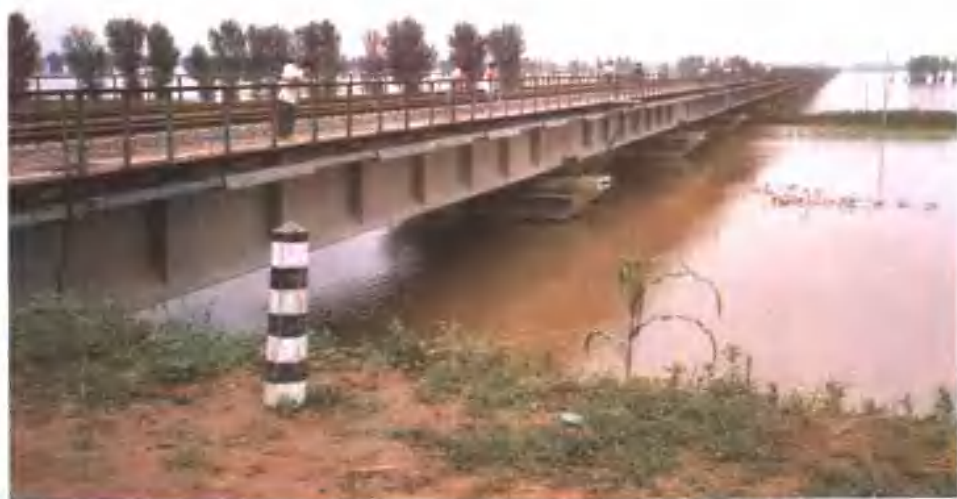
◀ 铁一院负责 工程建设监理 建成的京九线 湓流洼特大桥 在 1996 年洪水 中安然屹立
