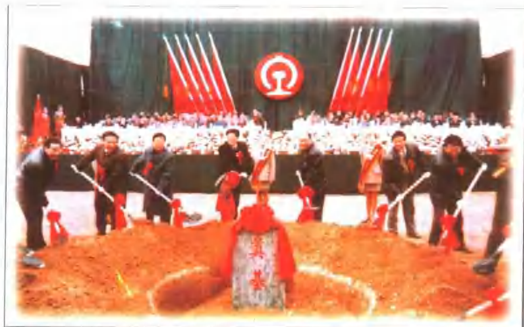
▲ 铁道部部长韩杼滨（左四） 等为西安安康线开工奠基
