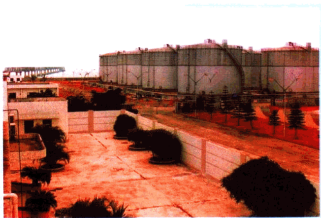
碣石湾5000吨级成品油码头与24000吨油库
