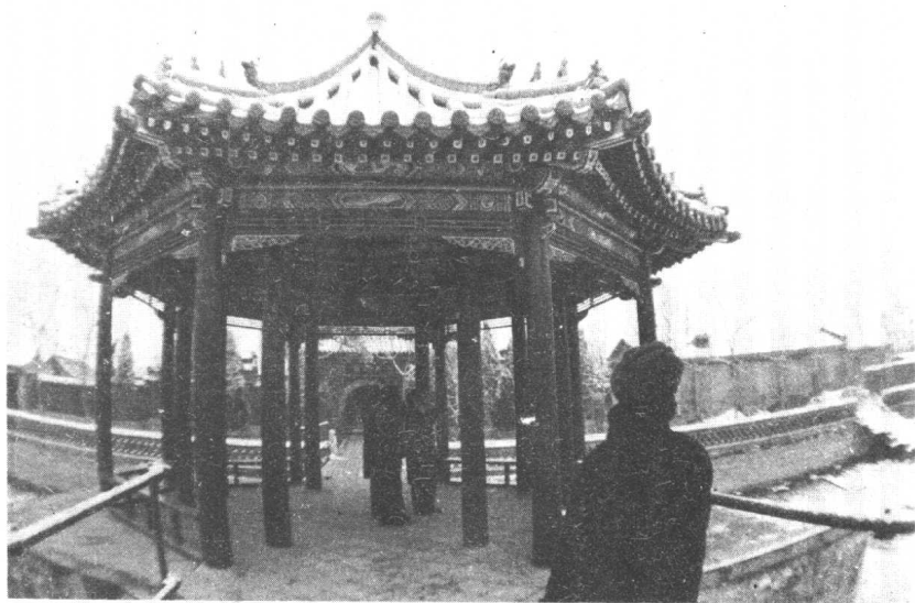
黄粱梦又称吕翁祠，位于邯郸市北10公里处黄粱梦镇。主体建筑有莲池、八角亭、五朝门、汉钟离殿、吕祖殿、卢生殿等。图为八角亭。
