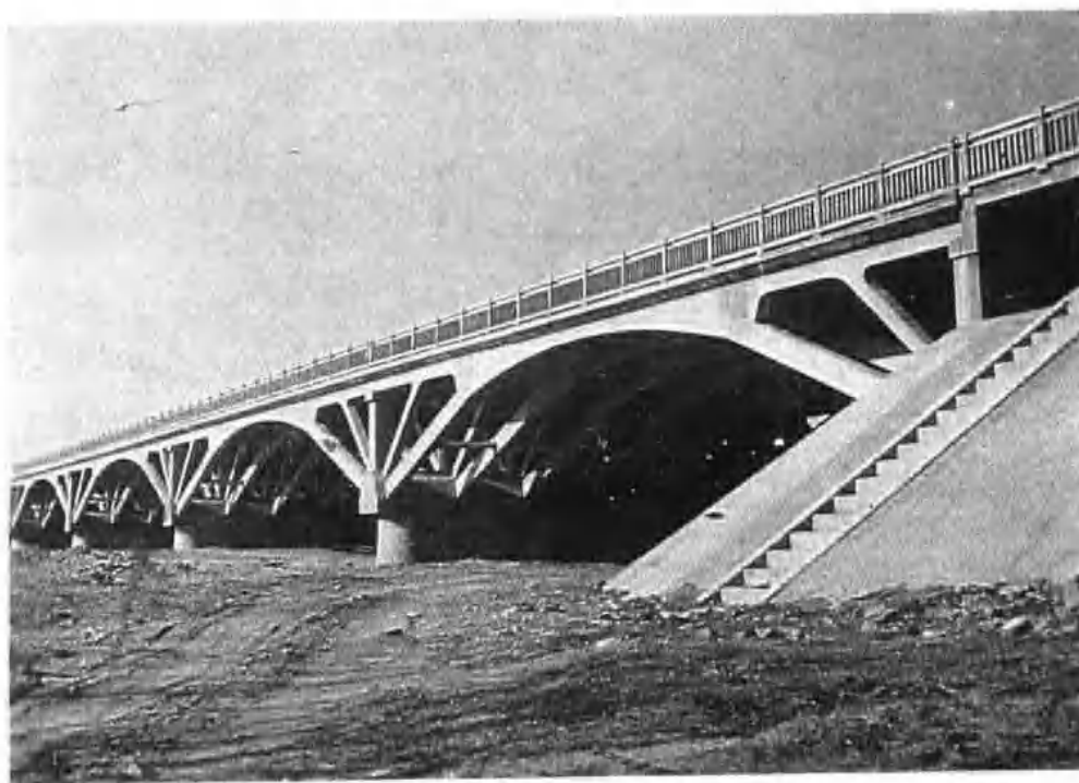
烟青一级公路莱阳清水河大桥
