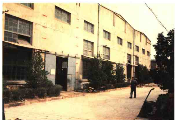
被城建档案救下来免拆除的 矿山机械厂金工车间
