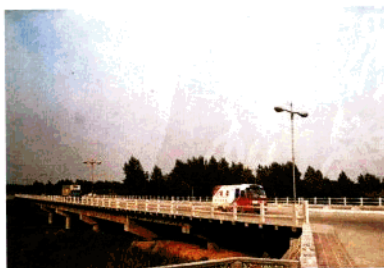
东环路洳河大桥
