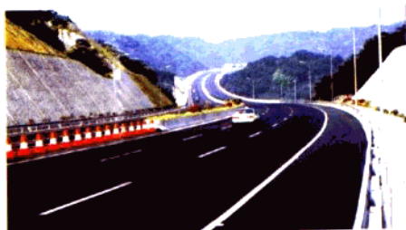
北二环高速公路
