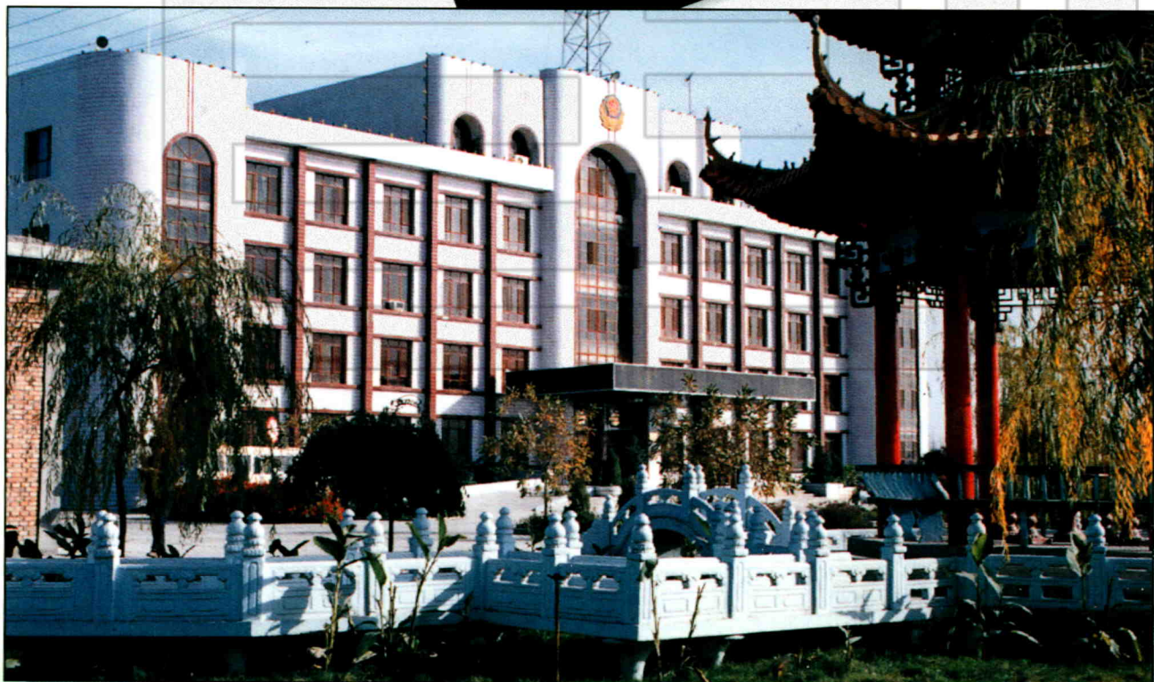
支队办公楼及庭院一角
