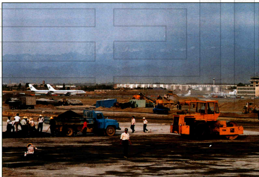
正在扩建中的乌鲁木齐国际机场
