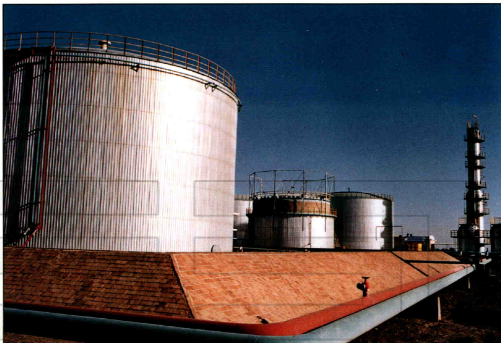
我国目前最长的沙漠输气管道彩南油田至克拉玛依油田管道建成投产,管道全长 294 千米,设计输气能力每天 180 万立方米
