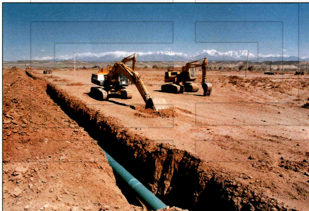
正在建设中的鄯善至乌鲁木齐石油液化气输气管道
