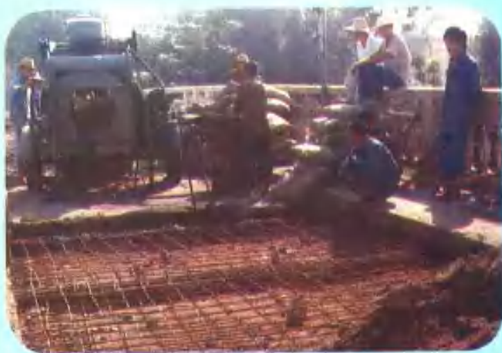
▲大桥施工。(黄治虞摄)
