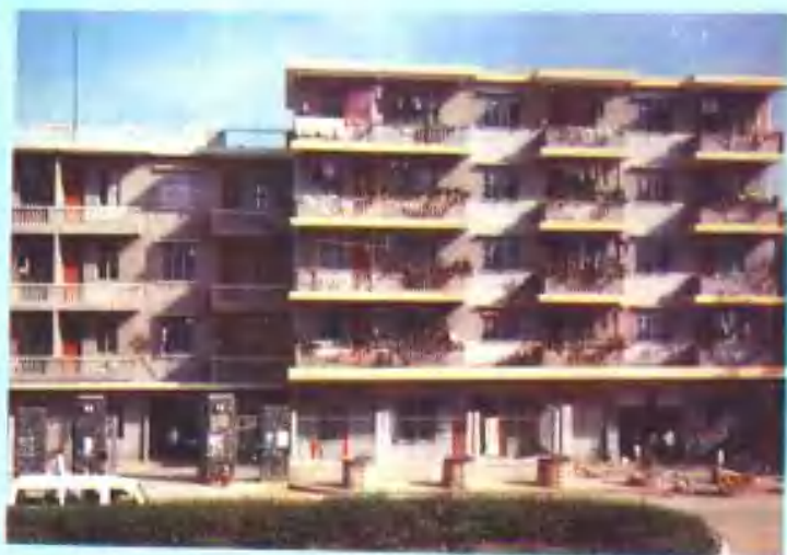
▲南雄县公路工区办公大楼。
