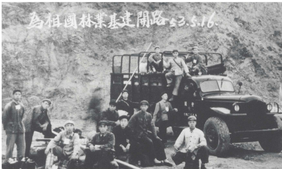
修建林区公路
