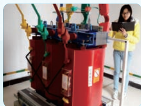
7.待设备进场完毕，调试后记录入册
