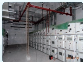
6.高压电缆桥架安装
