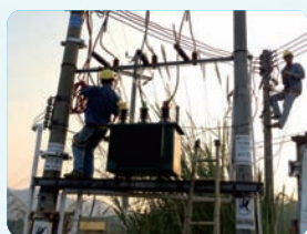
4.新建台区作业
