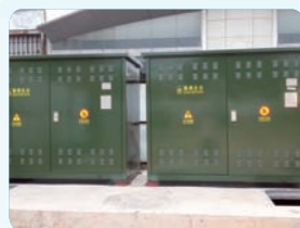
3.高压外接线的确定-接分接箱
