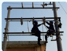
9.隔离开关的安装与调试
