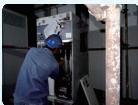
8.配电柜接电缆头
