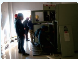
8.供电部门人员对该工程进行检验验收
