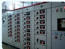
9.该工程通过检验后进行通电
