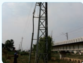
1.日常巡视线路
