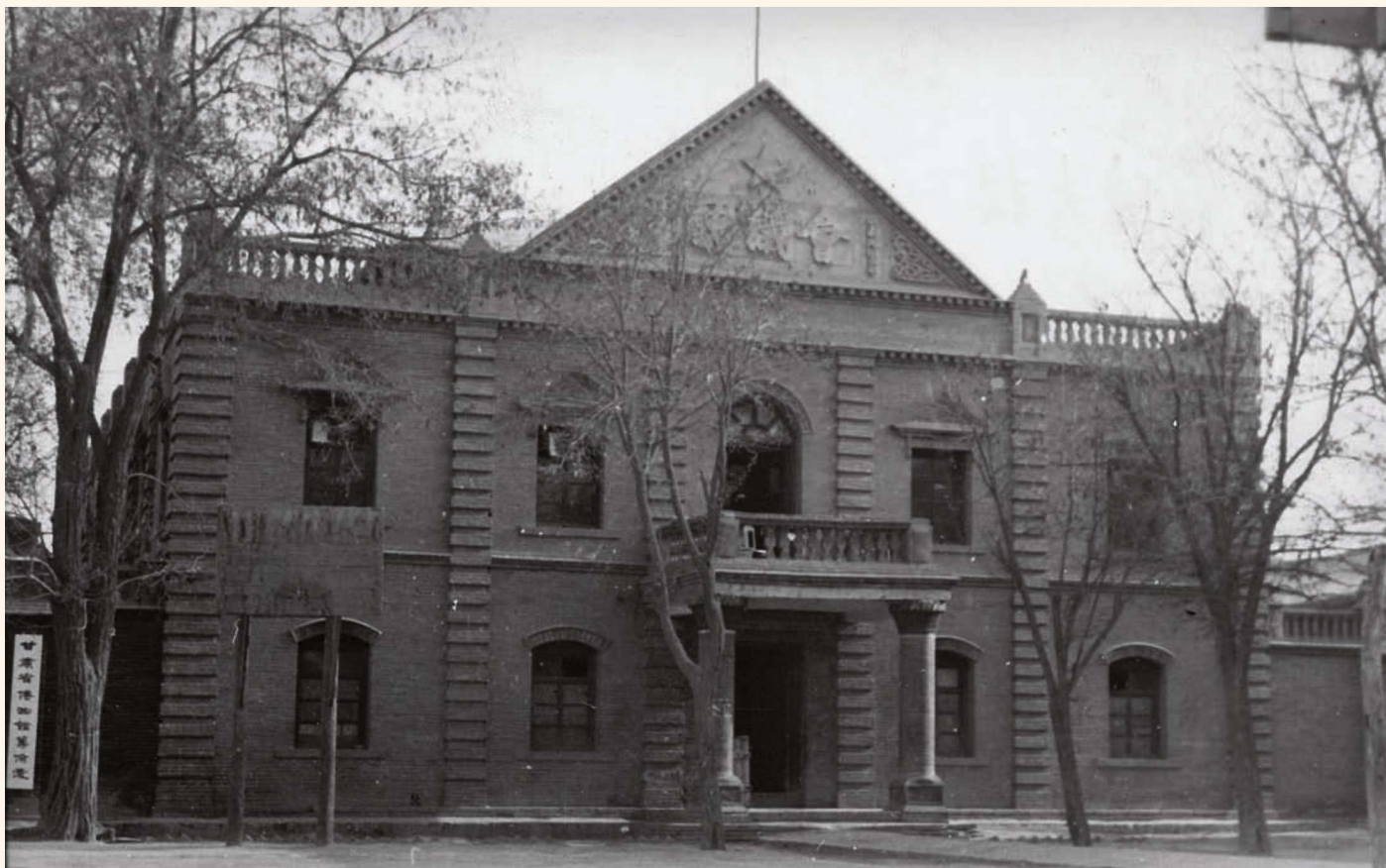
甘肃省博物馆筹备处前楼，左侧为“甘肃省博物馆筹备处”牌匾
