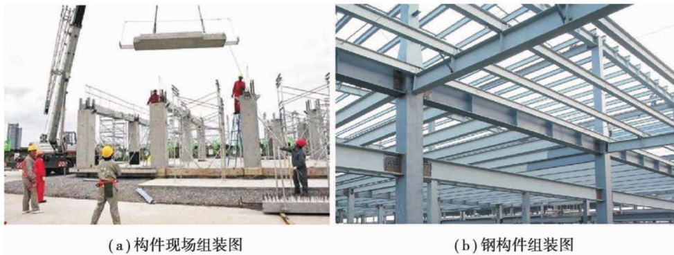
图 1.15 建筑构件安装
