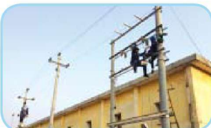
5. 训练场地的设备安装
