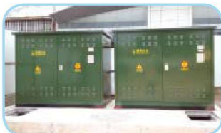
3. 高压外接线的确定—接分接箱
