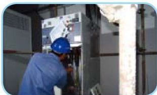
8. 配电柜接电缆头
