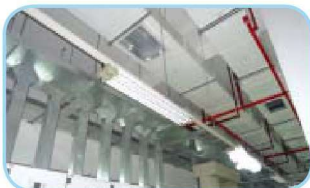
7. 配电柜母线安装
