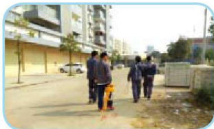
1. 寻找电缆位置
