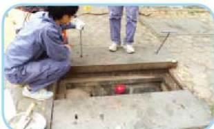
5. 安装电缆定位器
