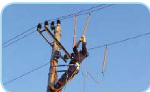
8. 登杆作业，挂接地线
