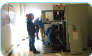
8. 供电部门人员对该工程进行检验验收
