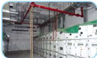
6. 高压电缆桥架安装
