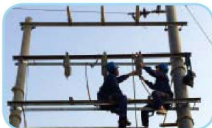
9. 隔离开关的安装与调试
