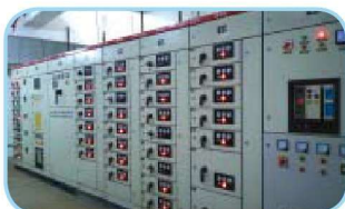
9. 该工程通过检验后进行通电
