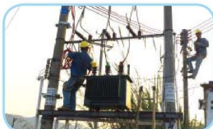
4. 新建台区作业
