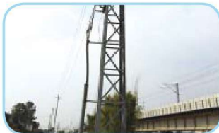
1. 日常巡视线路
