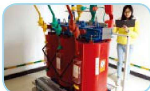
7. 待设备进场完毕，调试后记录入册
