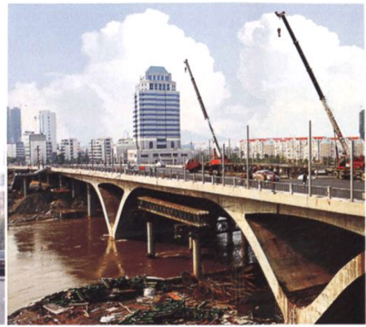
宜春袁山大桥（建设中）
