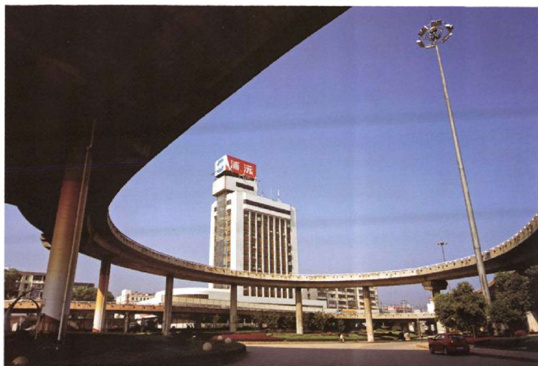
· 芙蓉南路立交桥
