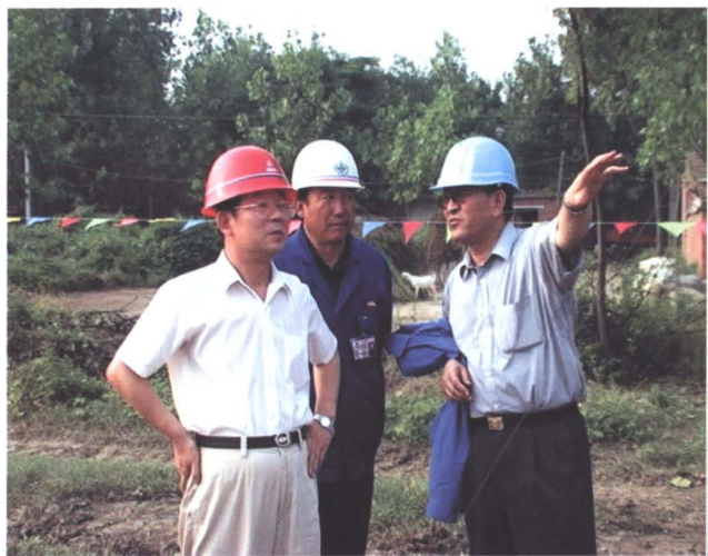
2002年6月，集团公司副总经理陈耕（左一）到公司西气东输（安徽段）施工现场检查指导工作
