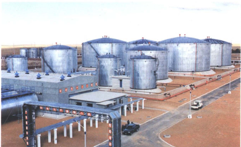
公司施工的防腐保温工程
