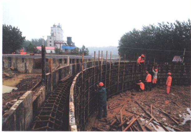
公司施工的大型油罐基础工程
