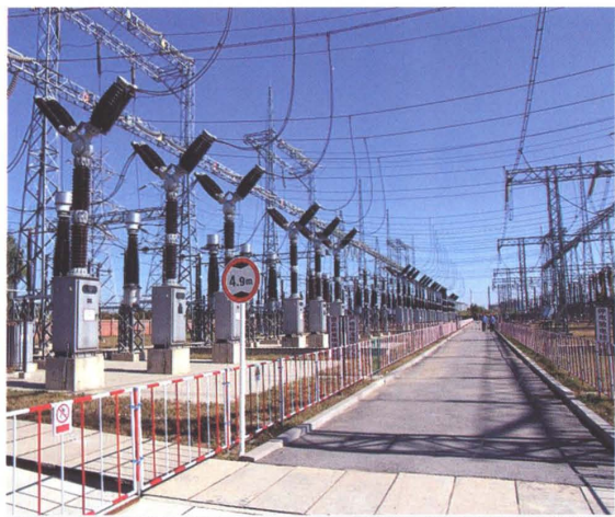
公司施工的输变电工程
