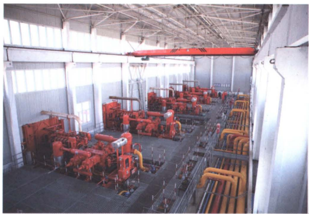
公司施工的苏10-3号大型压缩机安装工程
