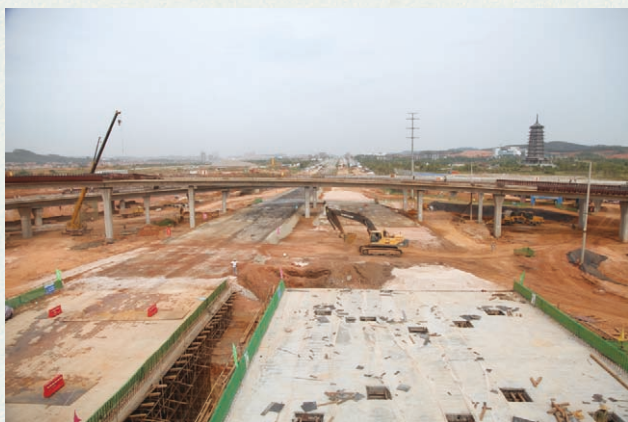
2015年7月2日，平乐——玉洞立交桥项目正在紧张施工
