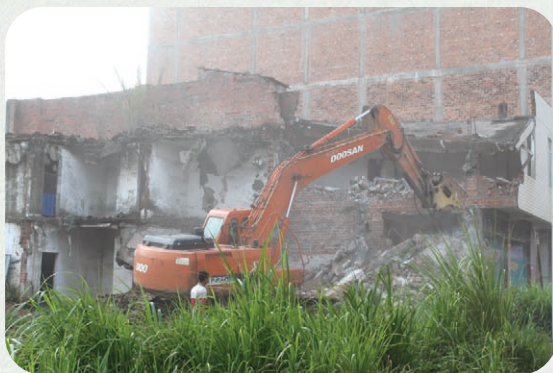
2015年7月30日，良庆区组织对玉洞村违法建筑进行拆除
