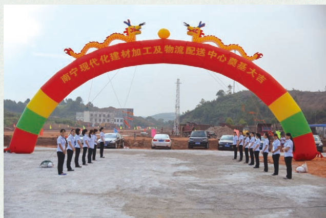
2015年9月15日，位于五象新区的现代建材加工及物流配送中心基地奠基
