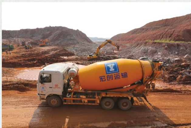
2015年9月15日，西片区施工现场
