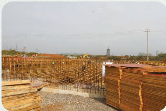
2015年12月，在建的五象新区项目工地
