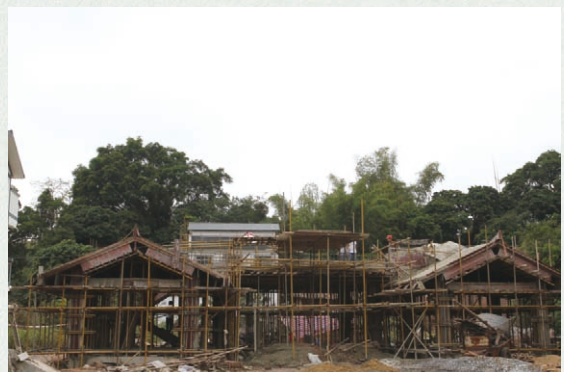
2015年11月6日，在建的大塘平天坡生态示范村
