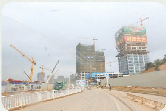
2015年11月19日，建设中的五象新区项目
