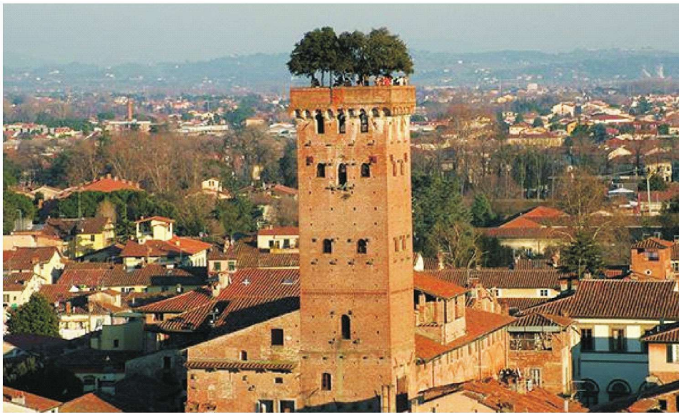
图 1-2 橡树塔屋顶花园
