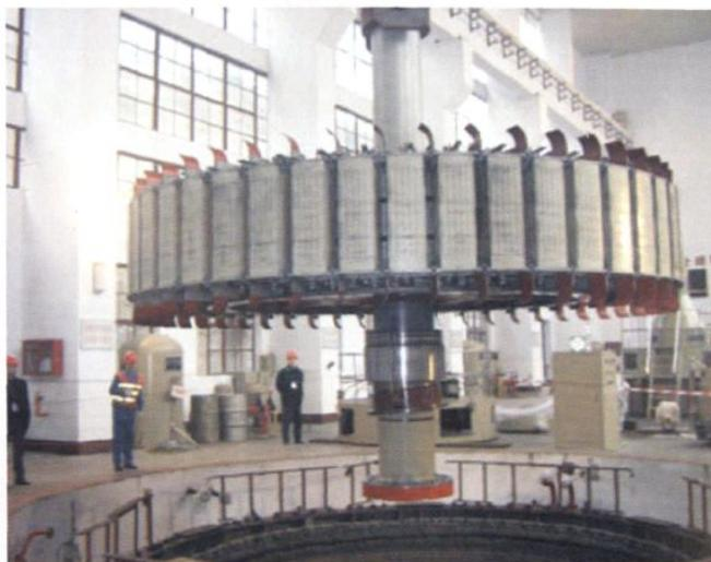
金华水电有限责任公司3G转子吊装
