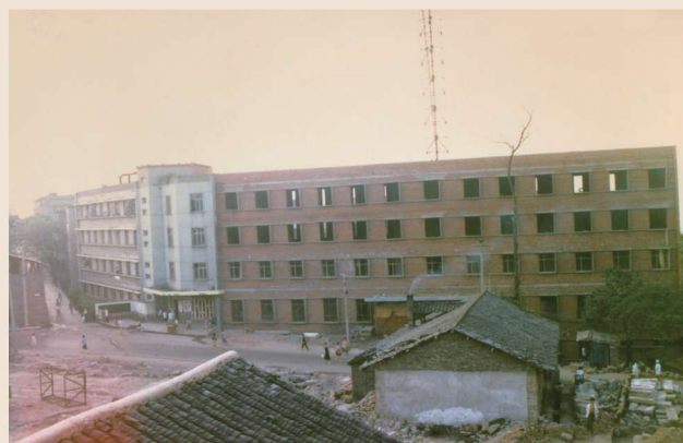
医院西门旧址门诊大楼竣工
