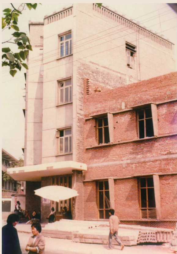
医院西门旧址门诊大楼施工（2）
