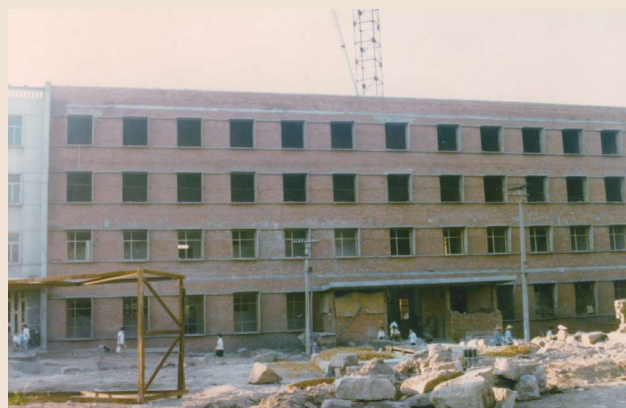
医院西门旧址门诊大楼施工（1）
