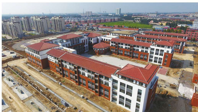
建设中的大王镇实验小学
