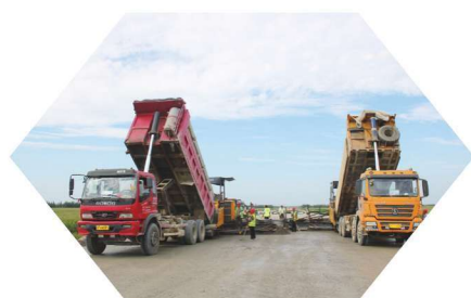
中关大道开工建设
