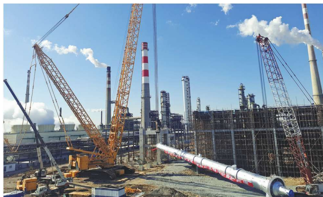
华星集团油品质量升级项目建设现场
