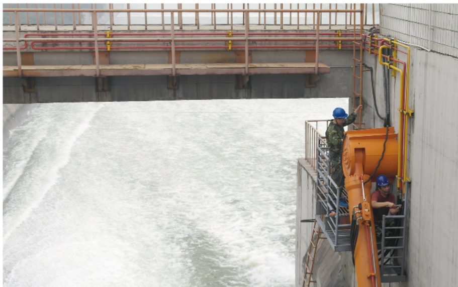
泄洪期间，机电组工作人员维护保养启闭机等机电设备。（殷立科 摄）
