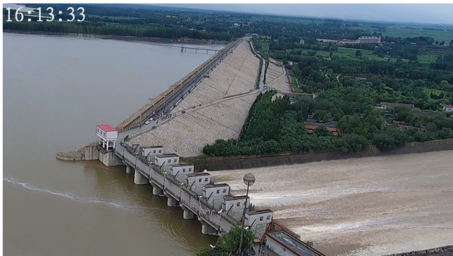
7月20日下午，黄壁庄水库正常溢洪道泄洪800立方米每秒实时监控画面。（霍云峰 摄）
