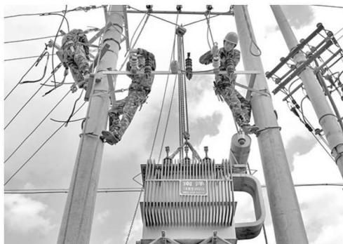
图 1-3 安装 10kV 配电变压器
