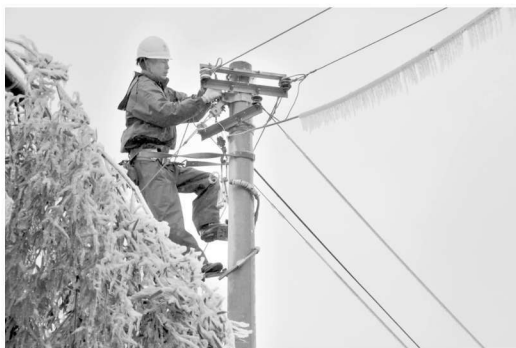
图 1-4 抢修低压线路
