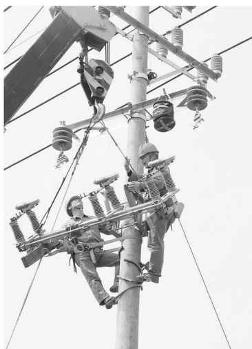
图 1-2 安装 10kV 隔离开关
