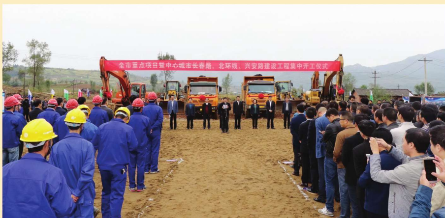
2016年10月11日，全市重点项目暨中心城市长春路、北环线、兴安路建设工程集中开工。
