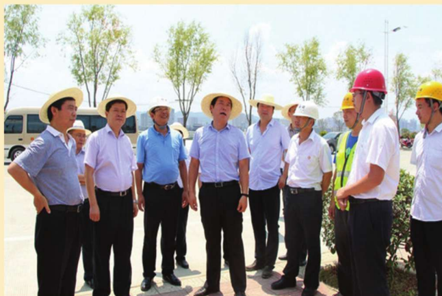
2017年8月3日，市长赵俊民（前排左四），副市长何邦军（左一）来到汉江大剧院施工现场，视察调研项目进展情况。
