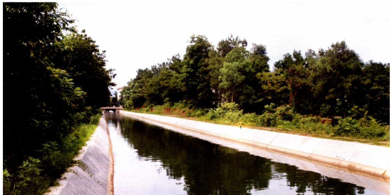
流经白沙村的峡口水库西干渠
