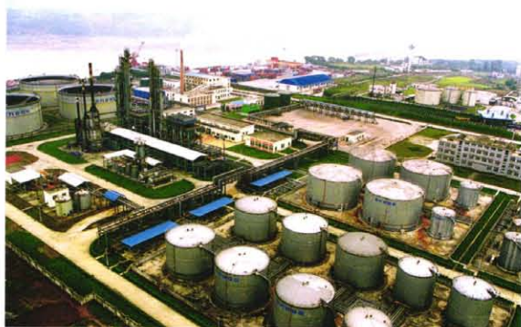
中海沥青（四川）有限公司厂区
