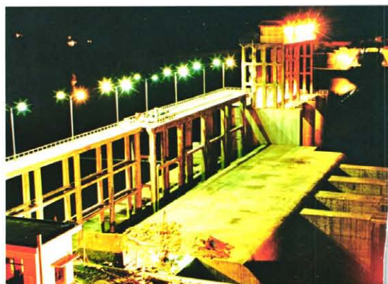
泸县流滩坝电站
