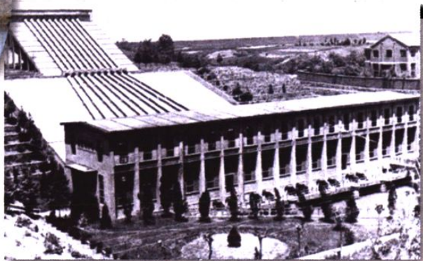
淳东抽水站北站
