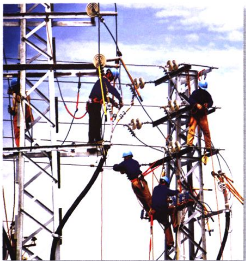
供电人员高空作业
