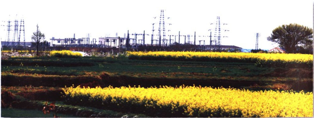
固城秀山变电站
