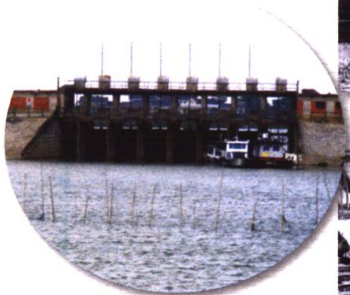
杨家湾水利枢纽节制闸
