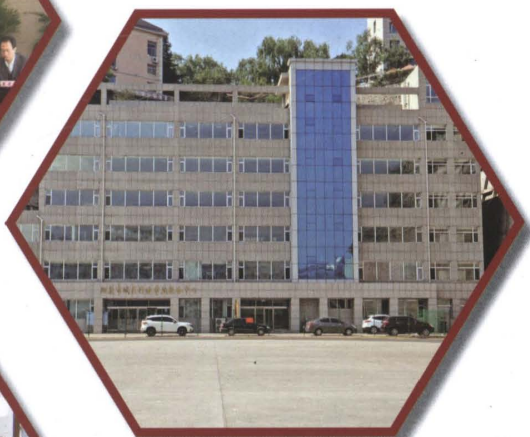
◎ 阳泉市城区智慧城区综合信息指挥平台
