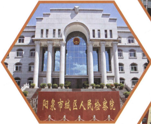
◎阳泉市城区人民检察院技侦大楼
