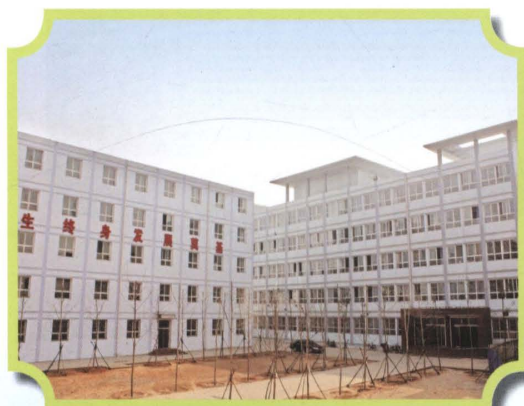
◎阳泉七中实验楼、新建综合楼
