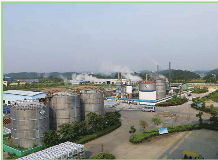
广西越洋化工集团一角
