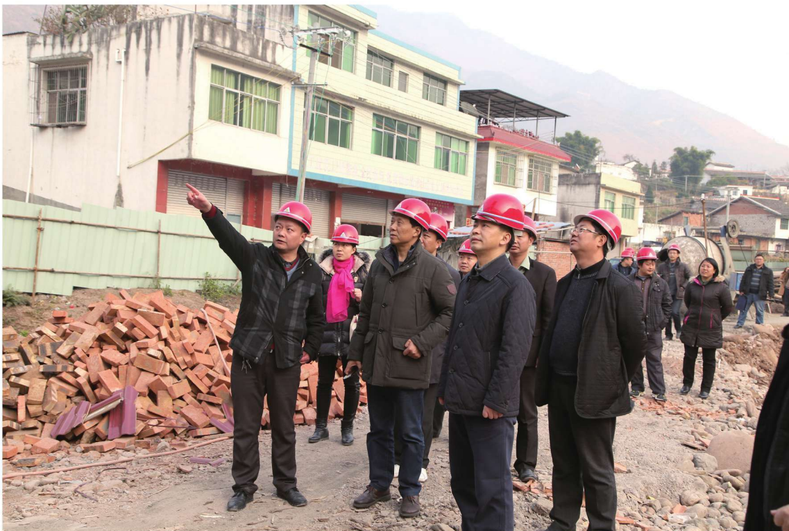
中纪委扶贫办主任钱武军（前排左二）调研正在建设中的前进乡桥头村活动室
