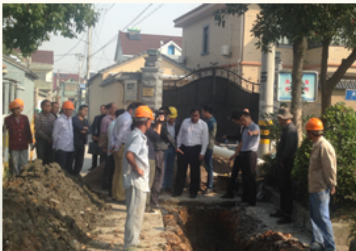
▲泗门镇人大检查农村生活污水截污纳管工程
