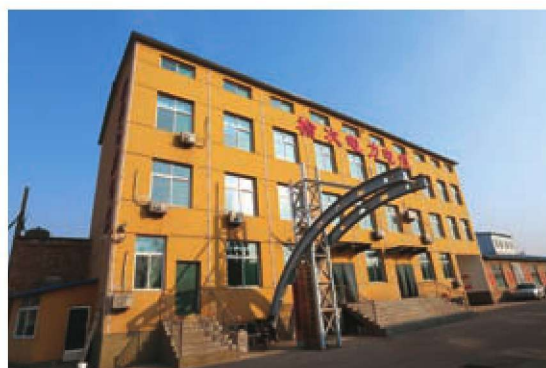
◎王湖电力电缆厂
