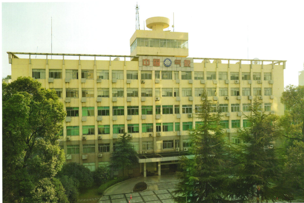
四川省气象局办公楼
