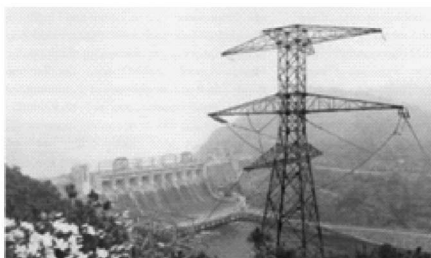
图 1.3 水力发电厂一角
