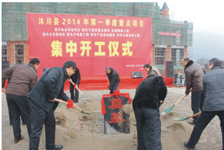
2月18日，沐川县举行第一季度项目集中开工仪式
