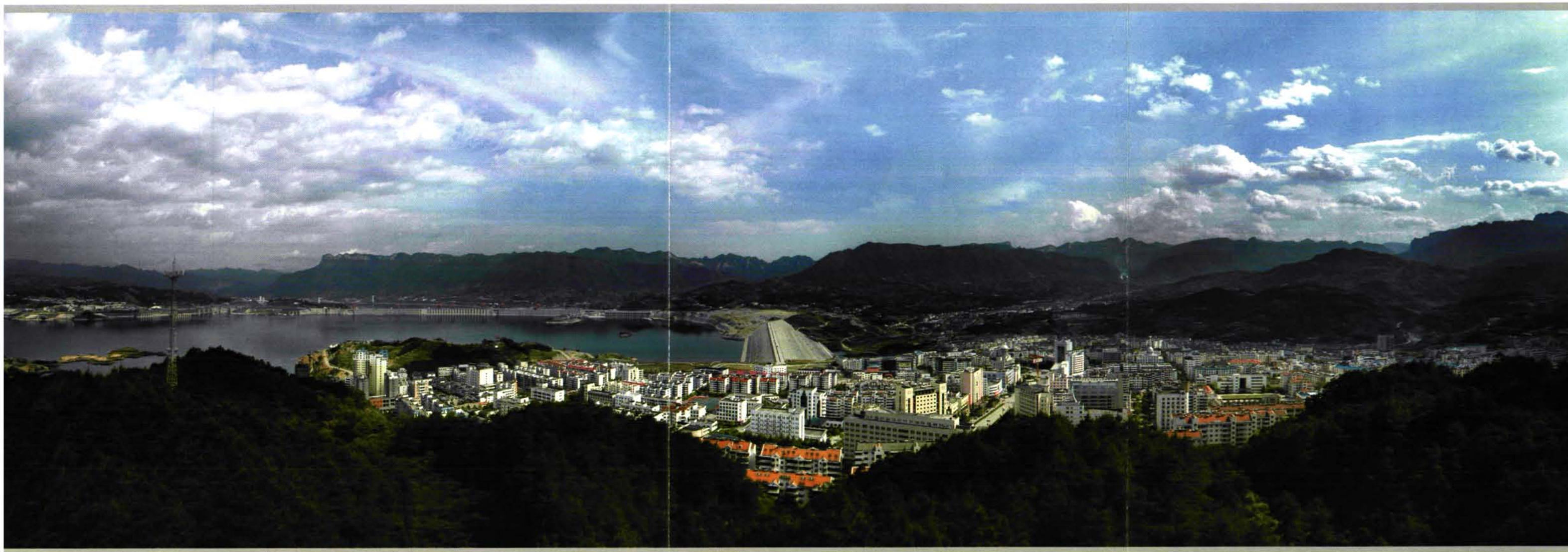
三峡工程大坝库首第一城——秭归新县城
