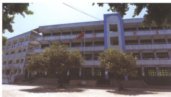
腾达镇中心校教学楼
