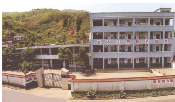
水茨村小学教学楼
