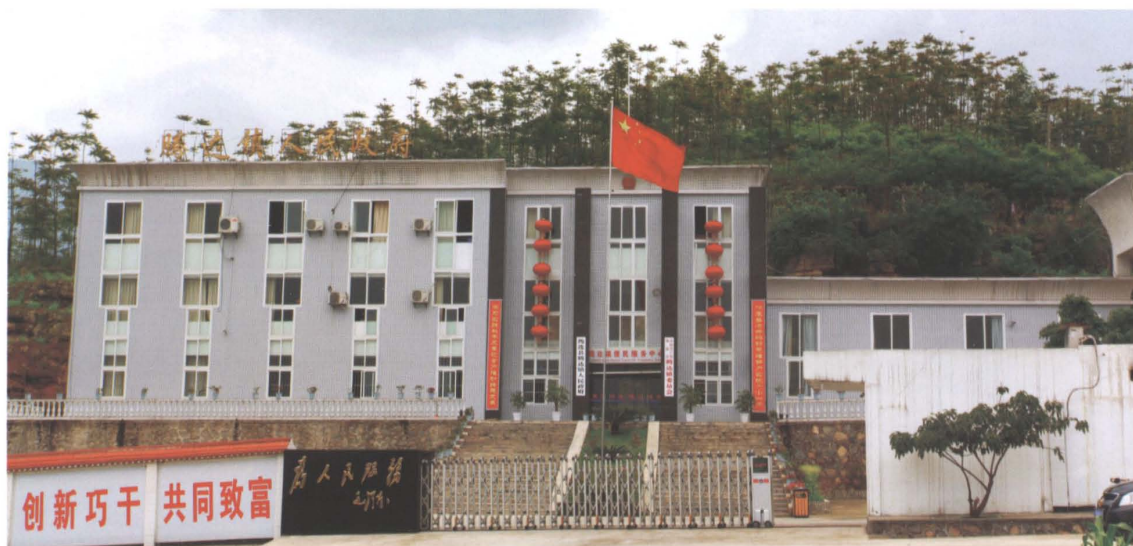
腾达镇党委、政府办公楼
