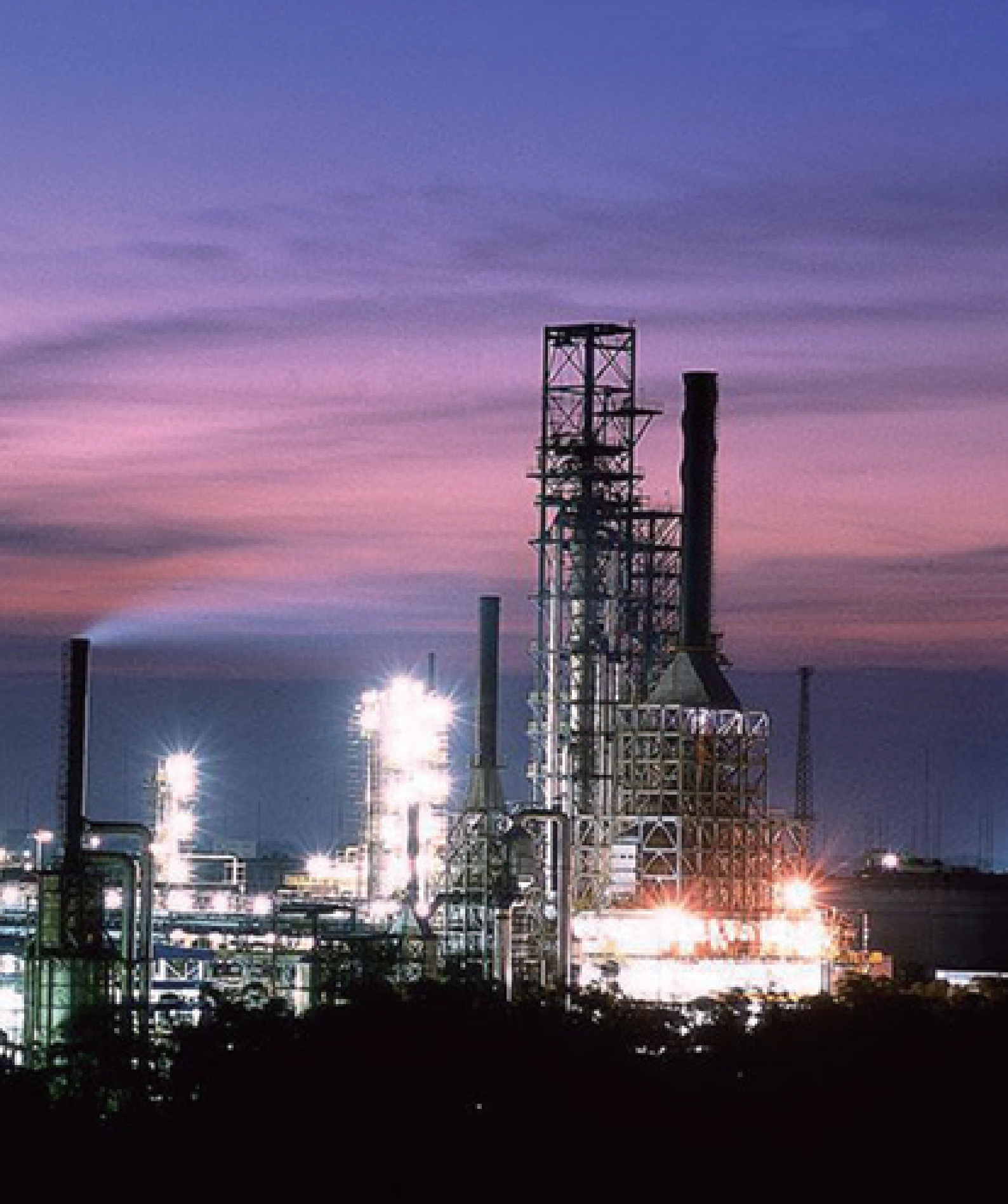
洛阳石化炼油厂夜景
