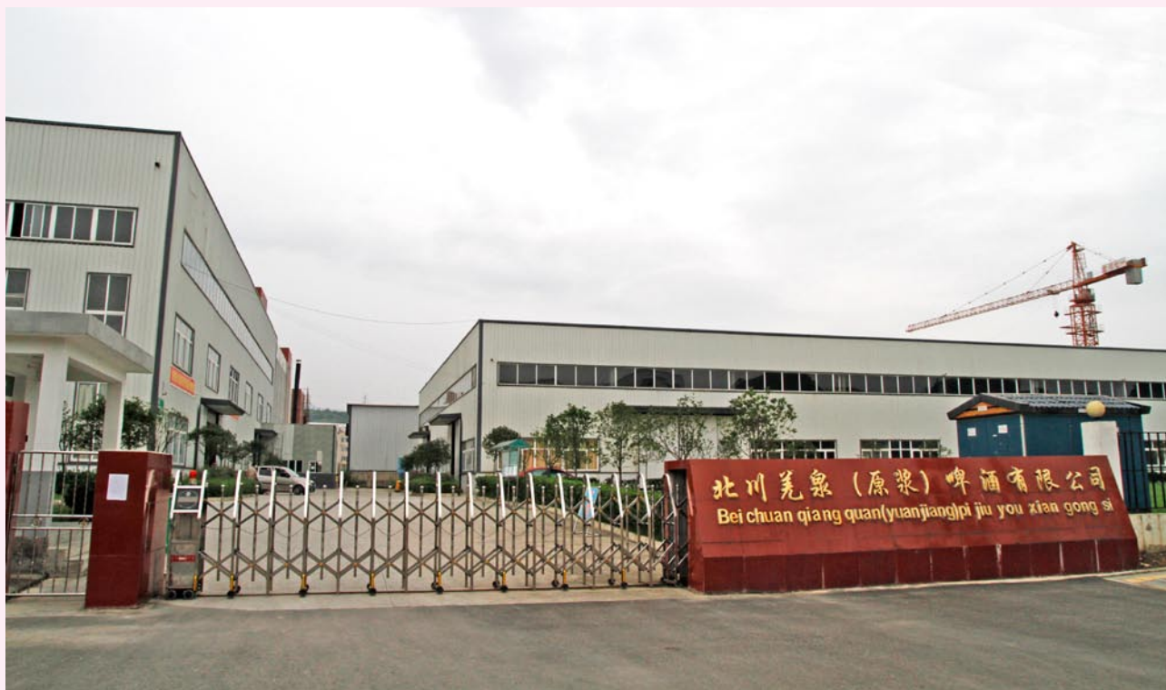
2011年4月竣工的北川羌泉(原浆)啤酒有限公司
