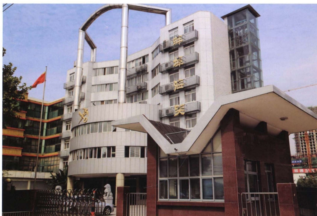
1997 年, 蚌埠海关办公楼 (蚌埠市涂山路 343 号)
