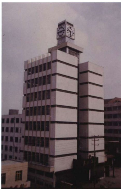
1988年,芜湖海关办公楼 (芜湖市九华山路478号)
