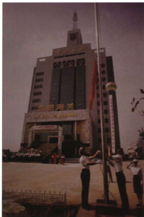
1997 年 6 月,合肥海关办公楼 (合肥市长江西路 669 号)
