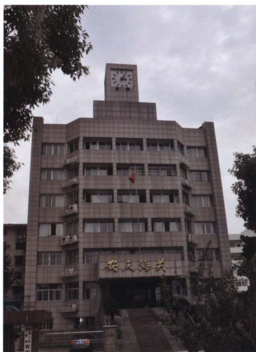
1988 年, 安庆海关办公楼 ( 安庆市沿江东路 172 号 )
