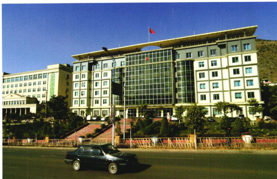
西区人民政府办公大楼
