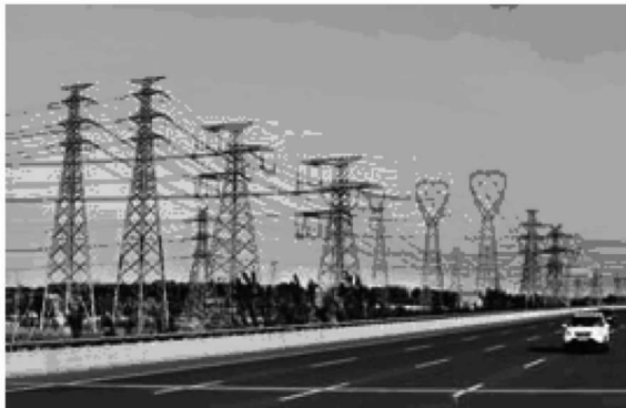
图 1-1 高压输电线路
