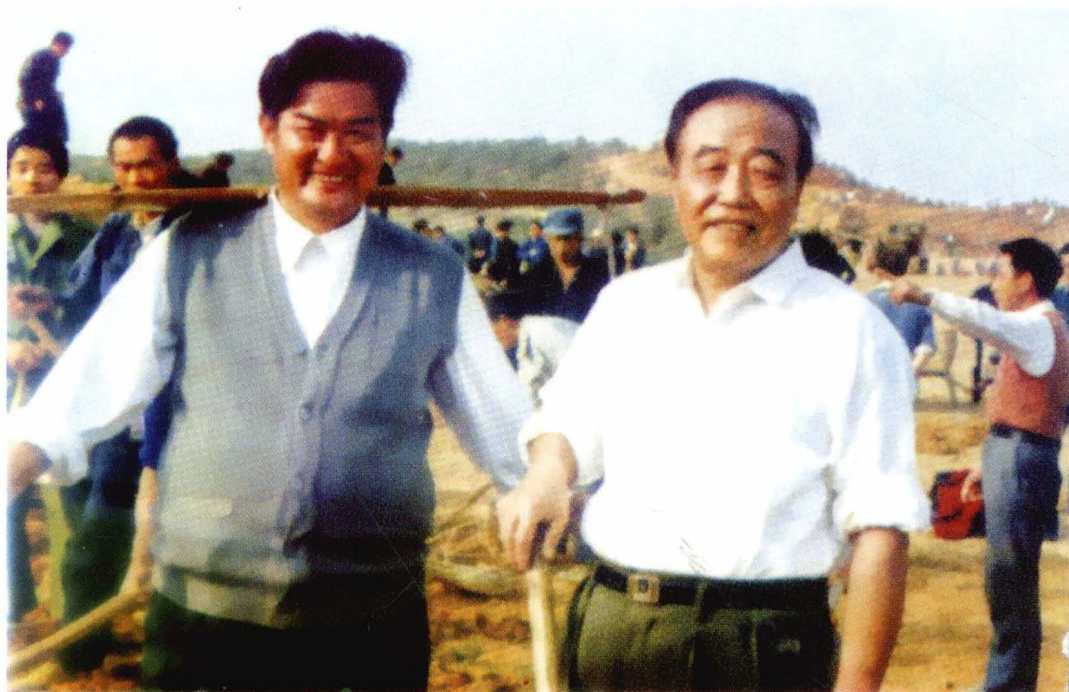
1992年11月，湖南省交通厅厅长李顺（右）考察207国道临澧段改建工地并参加劳动。
