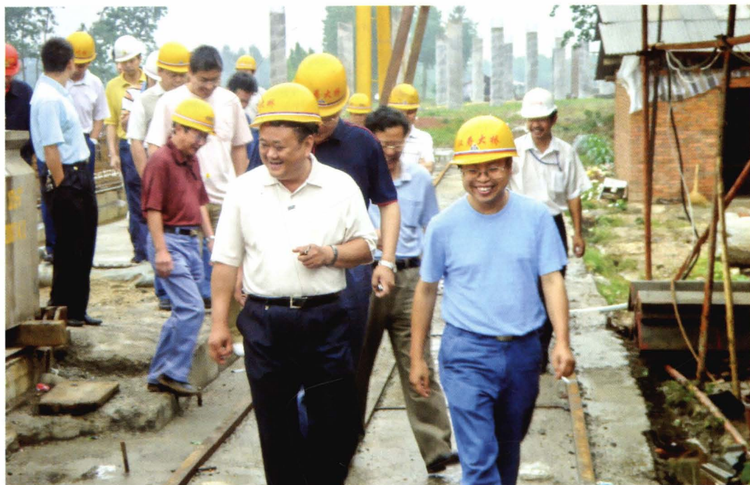
2007年5月24日，省交通运输厅副厅长詹新华（左一）考察汉寿沅水大桥建设工地。
