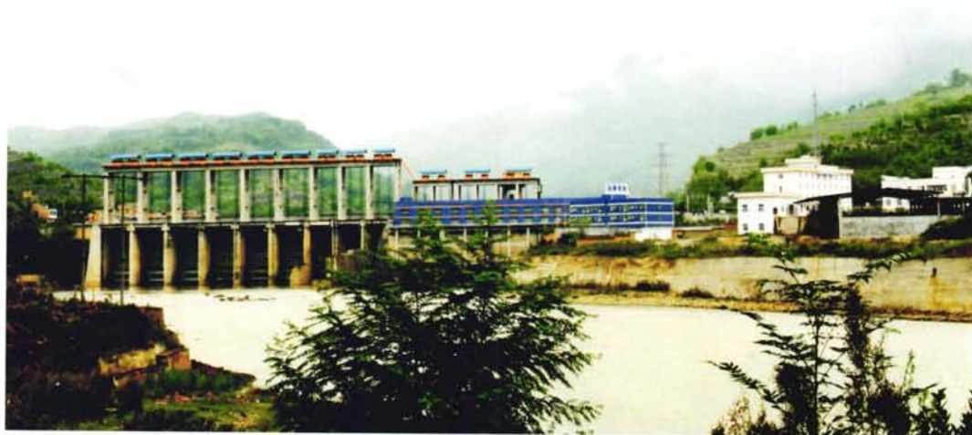
横江张窝水电站
