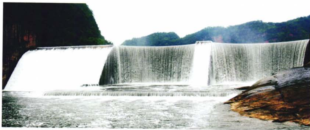
越溪河大塔滩电站大坝
