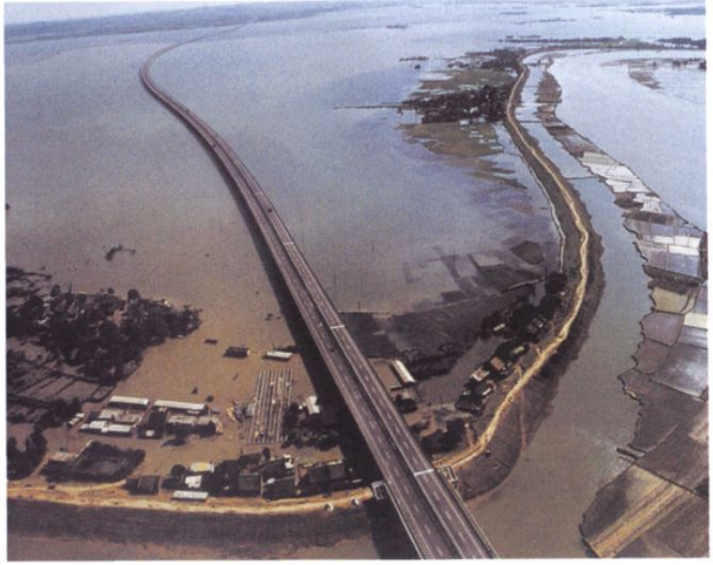
赣粤高速公路（药湖大桥）
